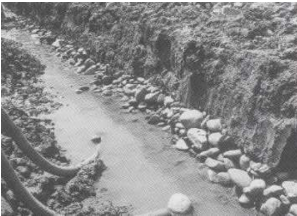
宝暦8年完成大樽川洗堰（洗堰の試掘）水うけ部
