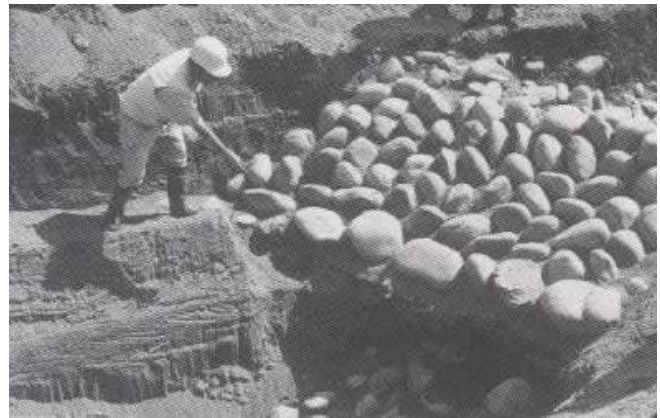
宝暦5年完成薩摩洗堰（洗堰の試掘）平成9年4月
